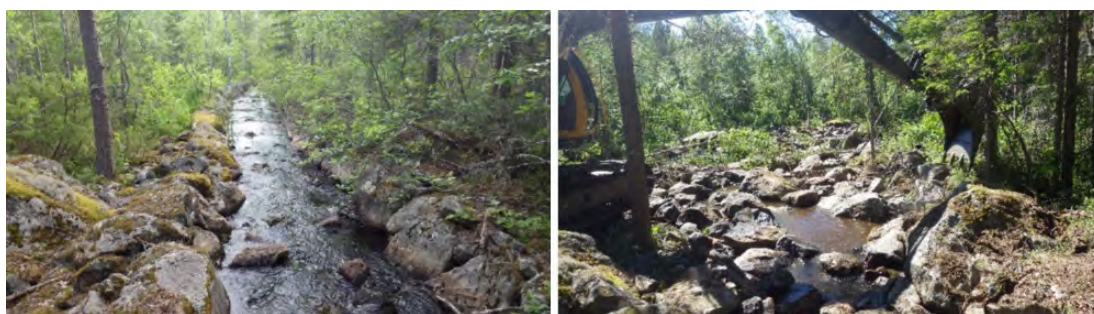
Figur 3.8: Restaurering av ett flottledsrensat vattendrag, här Kalvsån. Till vänster visas ett utträtat vattendrag anpassat till flottningen av timmer, och till höger visas samma vattendrag under pågående restaurering, foto Peter Hallgren, Fiskevårdstjänst.
