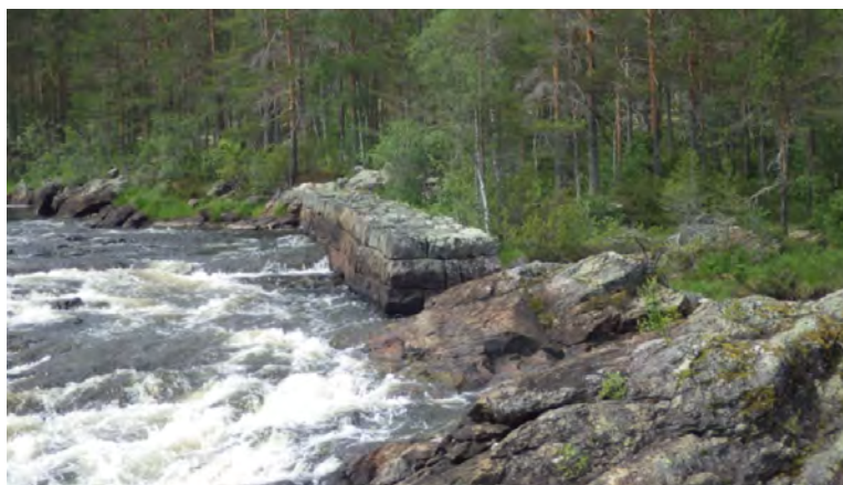
Figur 10.3: Stenkistor är kulturhistoriska lämningar efter flottningsepoken. Här syns en stenkista vid Hylströmmen som är extra stabilt byggd, foto Anders Persson/Linda Jonsson
