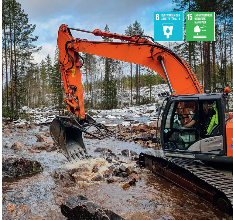
Arbete pågår i Västerhocklan. Foto: Anders Persson
